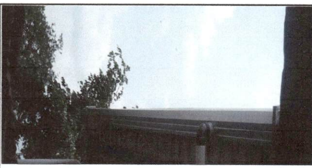
Foto 6: CANALES Y BAJADAS DE AGUA PLUVIAL
