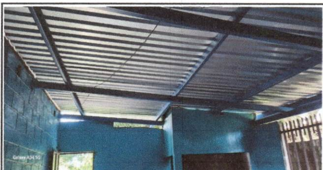
Foto 5: Sustitución de lámina, por lámina troquelada aluzinc calibre 26
