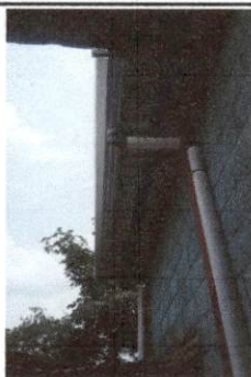
Foto 3: CANALES Y BAJADAS DE AGUA PLUVIAL
